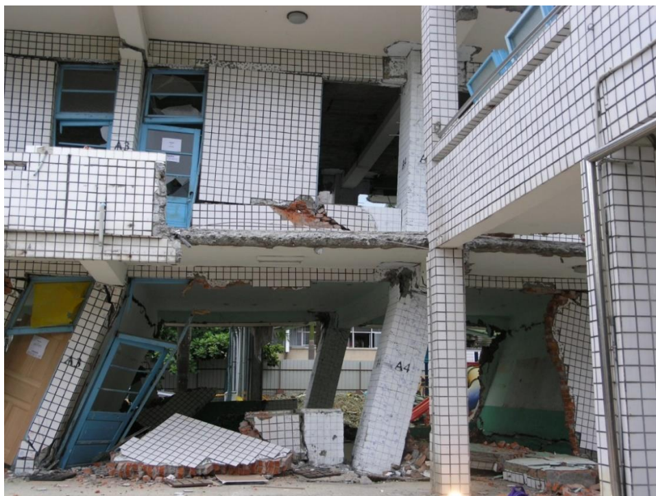
圖 5.49 擴柱(A4 柱)底端基礎翻轉[5.2]
