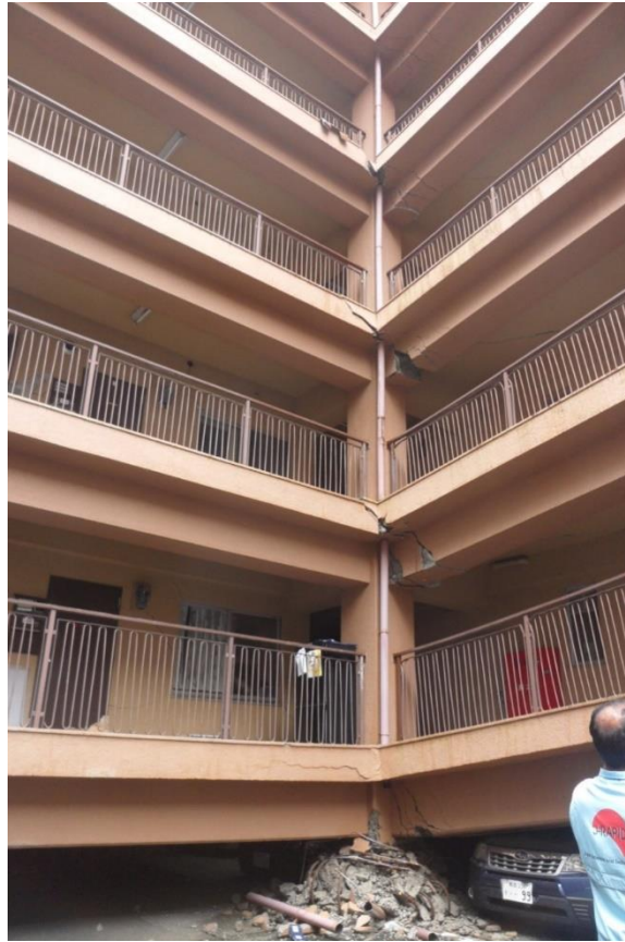
圖 1.3 日本熊本地震中某七層樓建築結構 (一樓崩塌，二樓樓版壓在車子上)(照片來源: 國震中心鍾立來博士)
