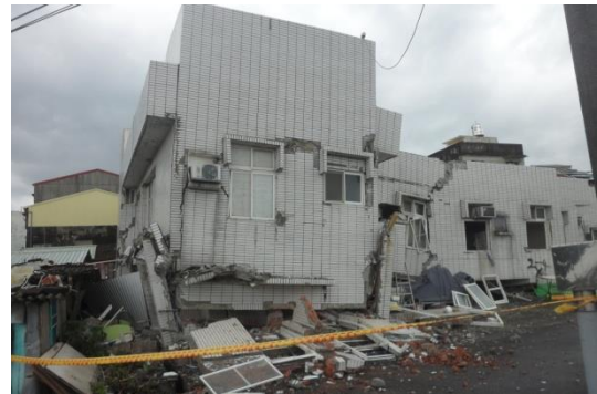
圖 1.3 日本熊本地震中某七層樓建築結構 (一樓崩塌，二樓樓版壓在車子上)(照片來源: 國震中心鍾立來博士)
