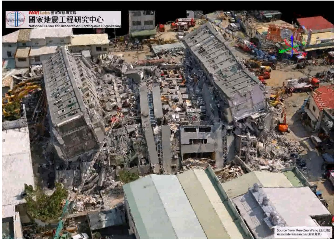
圖 1.2 台南市維冠金龍大樓倒塌後空拍照片 (照片來源：國震中心王仁佐博士)
